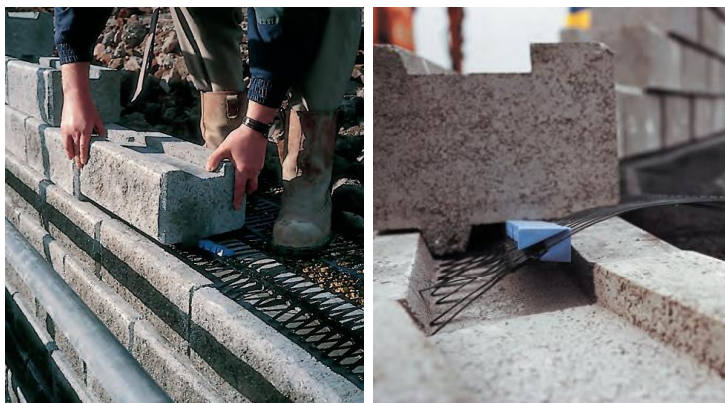
Pemasangan Multiblocks dan Geogrid
