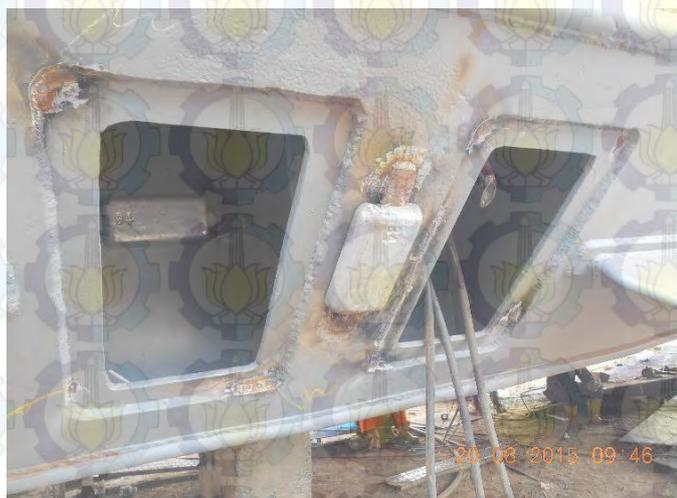
Gambar 2. 8 Pemasangan Zinc Anode dengan pengelasan
