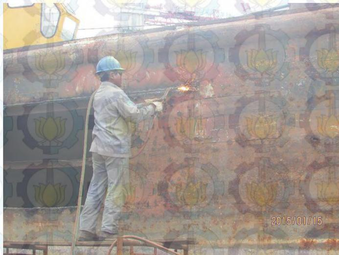
Gambar 2. 10 Pemotongan Pelat Kapal yang Rusak
