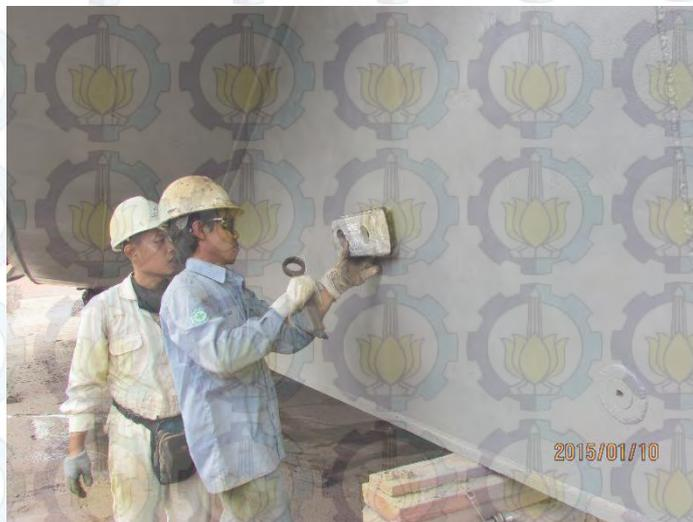
Gambar 2. 7 Pemasangan Zinc Anode
