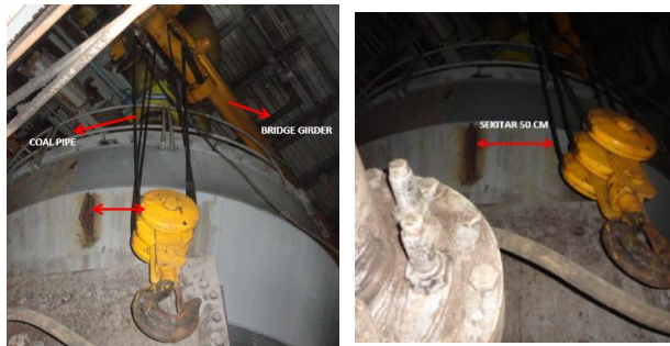
Gambar 2.6 Space Hoist Crane Dengan Beban
