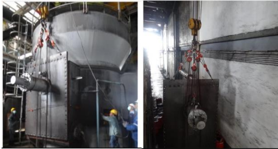
Gambar 2.4 Proses Pemasangan/Pelepasan Grinding Mill
