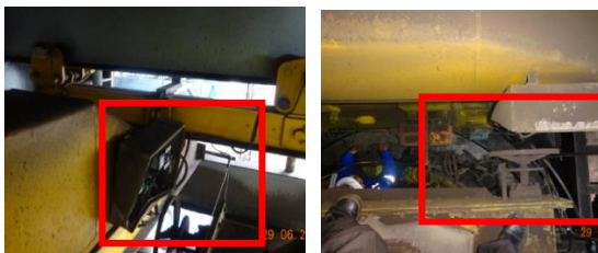
Gambar 1.2 Kondisi Panel Hoist Menyentuh Manual Valve
