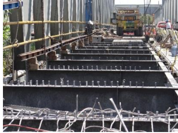
Gambar 1. 3 Perbaikan lantai kendaraan Jembatan Sembayat
