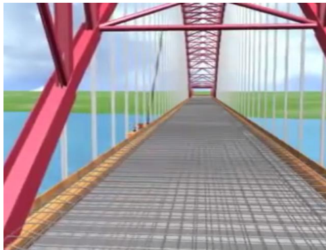
Gambar 2.30 Pemasangan bondek dan pembesian lantai kendaraan
