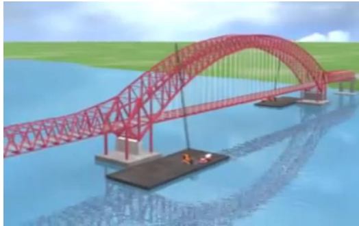
Gambar 2.29 Pembongkaran Temporary Tower dan Temporary Cable
