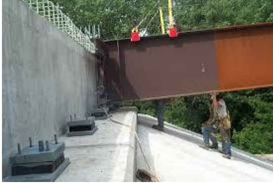
Gambar 6.6 Pemasangan Pot Bearing
