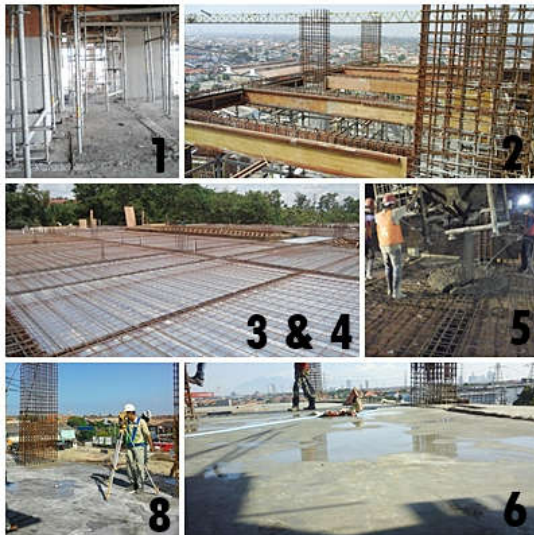
Gambar 8. 8 Tahapan Pelaksanaan Pekerjaan Balok-Plat Lantai
