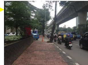
Kondisi Pedestrian Blok V
