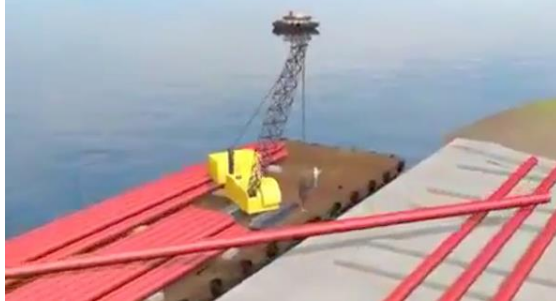
Gambar 8. 4 Pengangkatan Steel pipe pile dari Setting bad ke Pontoon
