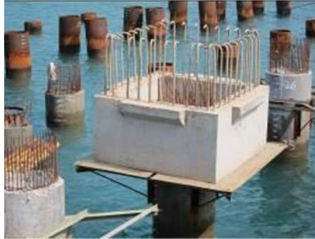
Gambar 8. 8 Pemasangan Pile Cap
