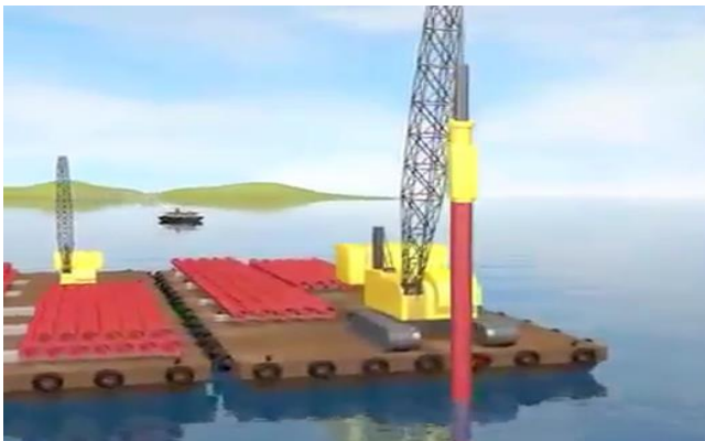
Gambar 8. 6 Pemancangan Steel Pipe Pile denga Hydrulic Hammer
