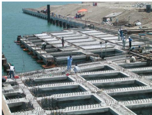
Gambar 8. 9 Pemasangan Balok Pracetak
