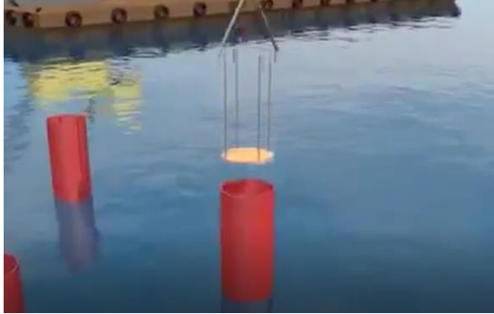
Gambar 8. 7 Pemasangan base plate
