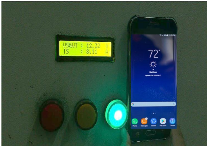
Gambar 4.28 Nilai Arus dan Tegangan Saat Terjadi Hubung Singkat Fasa R dan S
