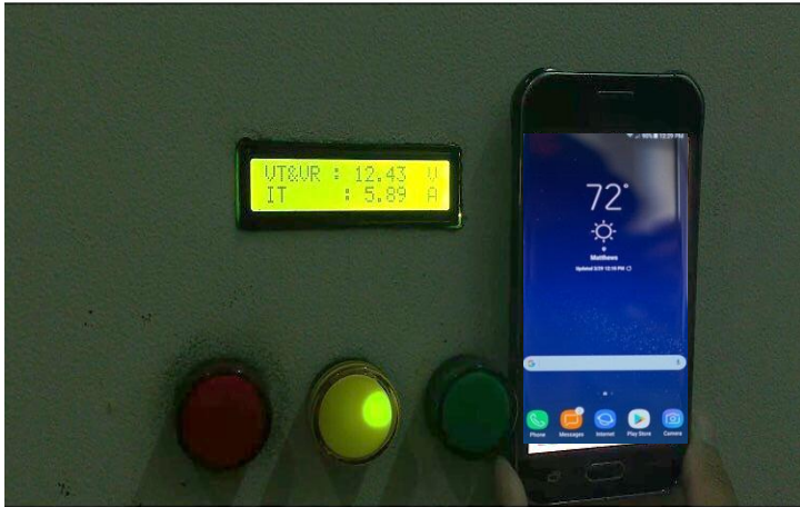
Gambar 4.31 Nilai Arus dan Tegangan Saat Terjadi Hubung Singkat Fasa R dan T
