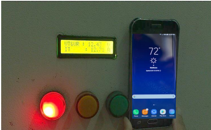
Gambar 4.25 Nilai Arus dan Tegangan Saat Terjadi Hubung Singkat Fasa S dan T
