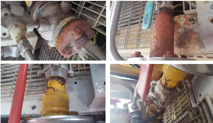
**Gambar 4.2** Terdapatnya Embun pada *Pressure Regulator* GTC - 653
