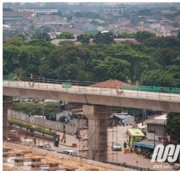
Gambar 5.1 *Span* yang Menumpu pada *Pier*
