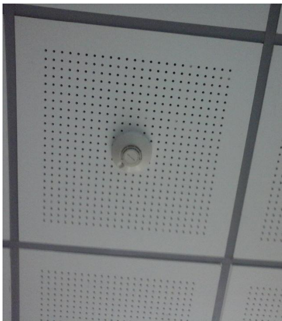
Gambar F.86 Perangkat Pemadam Otomatis
