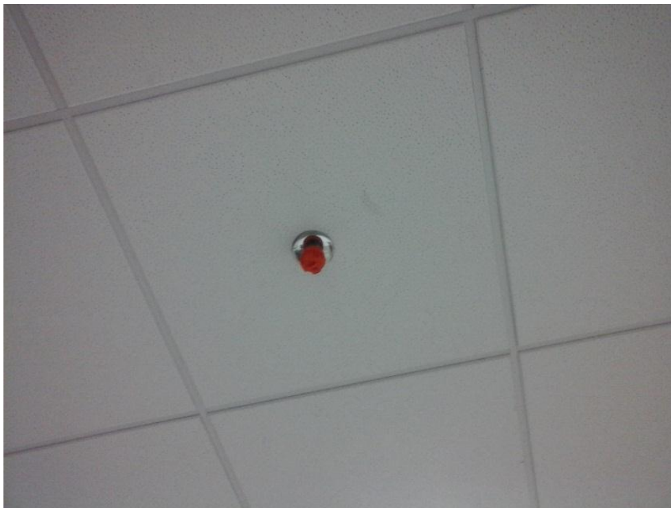
Gambar F.86 Perangkat Pemadam Otomatis
