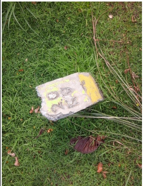
Gambar F.98 Patok Penanda Kabel Listrik
