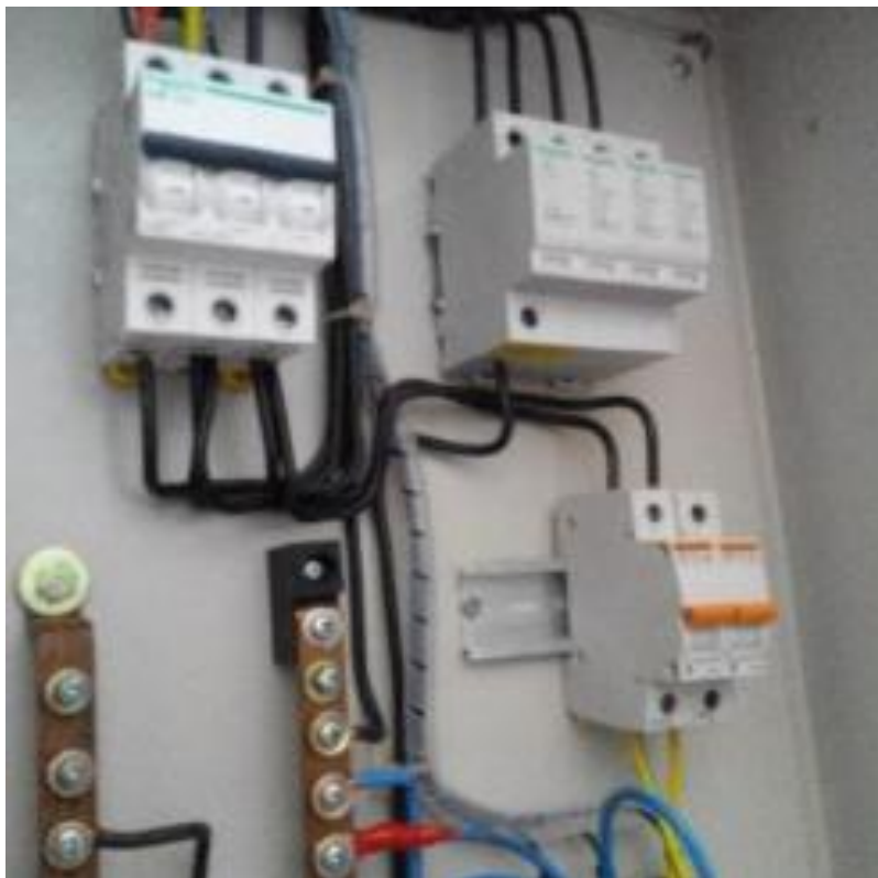
Gambar F.94 Perangkat Grounding
