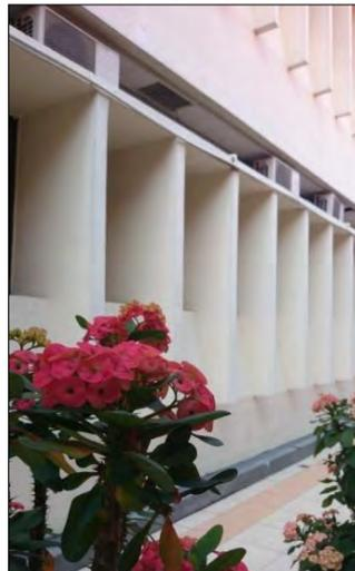
Gambar 4.15 *Shading devices* yang terdapat pada dinding bangunan
