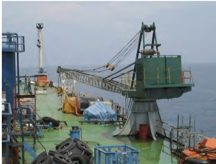
Gambar 4.60 Foto existing konstruksi bow crane pedestal pada FSO Arco Ardjuna
