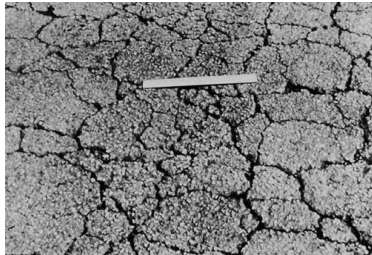
Gambar 2.2 Retak Kulit Buaya (Alligator cracking) Sumber: ASTM
