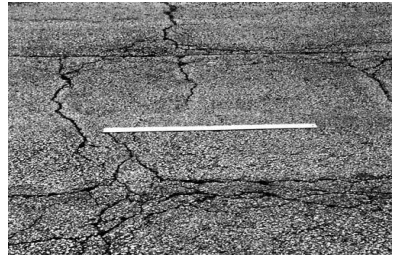
Gambar 2.5 Retak Blok (Block Cracking) Sumber: ASTM
