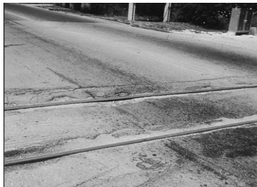
Gambar 2.15 Rusak pada Perlintasan Kereta Api ( Railroad Crossing ) Sumber: ASTM
