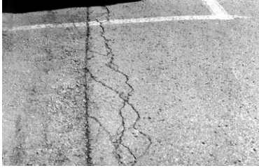
Gambar 2.8 Retak samping Jalan ( Edge Cracking ) Sumber: ASTM
