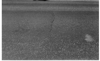
Gambar 2.11 Retak Memanjang atau Retak Melintang ( Longitudinal and Transverse Cracking ) Sumber: ASTM
