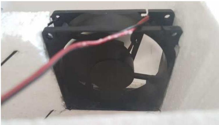
Gambar 4. 8 Kipas DC yang sedang beroperasi pada posisinya
