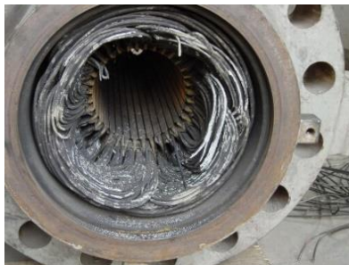
Gambar 2. 6 Kerusakan pada Stator
