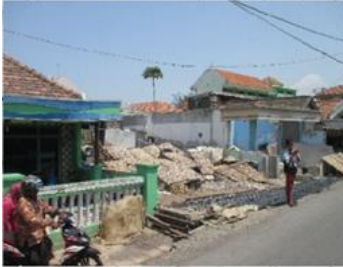
Gambar IV.1 Kondisi Fisik Bangunan RW 2 Kelurahan Kedung Cowek Sumber : Survey Primer, 2018
