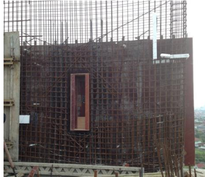
Gambar 10.5 Contoh Pemasangan Styrofoam (Sumber: Dokumentasi Pribadi Proyek Apartemen Taman Melati)
