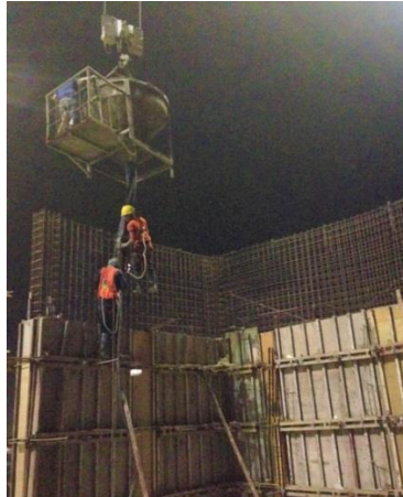
Gambar 10.11 Proses Pengecoran Shearwall dengan Concrete Bucket dan Pipa Tremi (Sumber: Dokumentasi Pribadi Proyek Apartemen Taman Melati)
