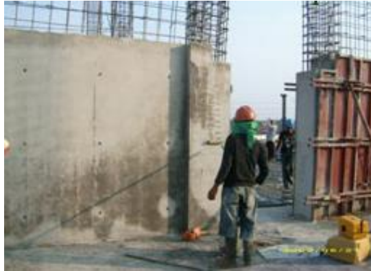
Gambar 10.15 Proses Curing pada Shearwall (Sumber: www.ilmusipil.com )
