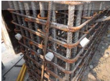
Gambar 10.6 Beton Decking pada Shearwall (Sumber: digilib.mercubuana.ac.id )
