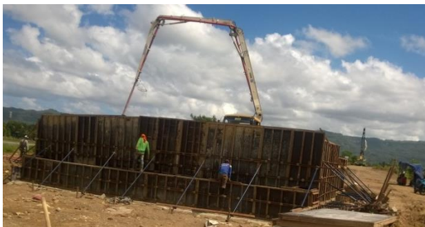
Gambar 9.7 Proses Pengecoran Bangunan Bawah Sumber: Buku TA Modifikasi Jembatan Girindulu Menjadi Busur Baja Oleh Hendra Darmawan
