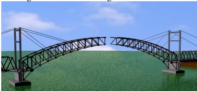
Gambar 9.17 Pemasangan Kabel Penahan Segmen 7
