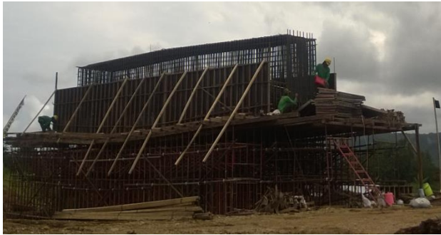
Gambar 9.6 Proses Penulangan Bangunan Bawah
