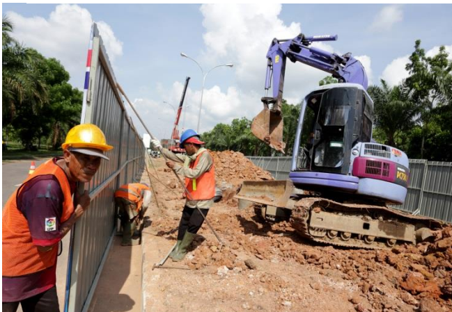
Gambar 9.3 Pembuatan Pagar Proyek
