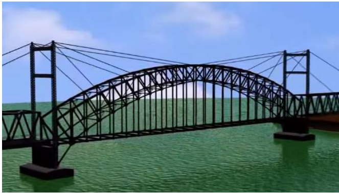
Gambar 9. 18 Pemasangan Kabel Jembatan & Gelagar Melintang, Memanjang
