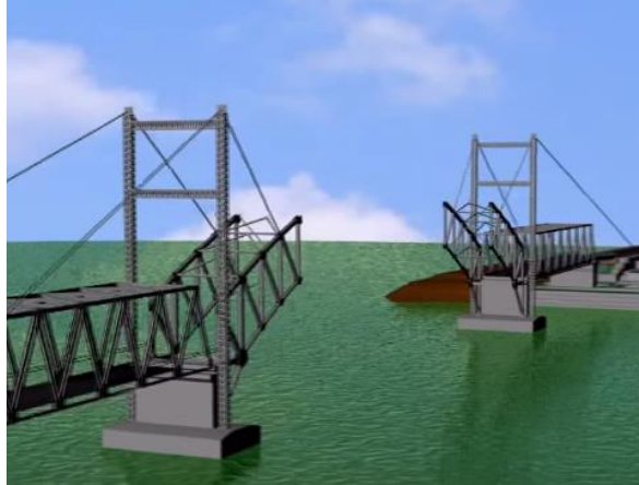
Gambar 9.15 Pemasangan Kabel Penahan Segmen 1
