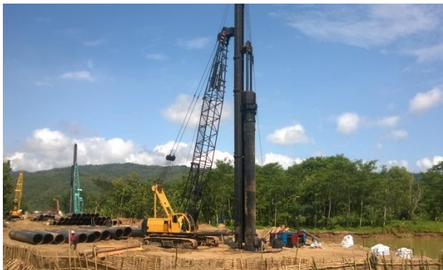
Gambar 9.5 Proses Pemancangan
