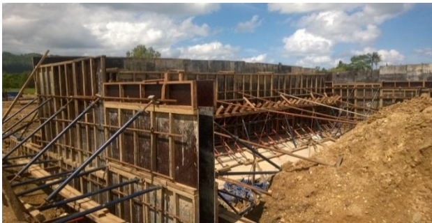
Gambar 9.8 Pemasangan Bekisting
