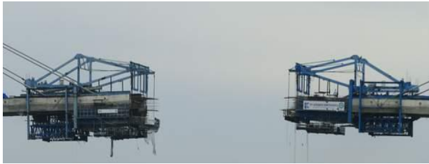
Gambar 9.12 Pemasangan Traveler
