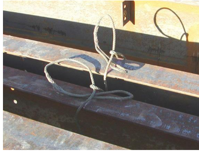
Gambar. 5 6 Ikatan sling pada balok baja
