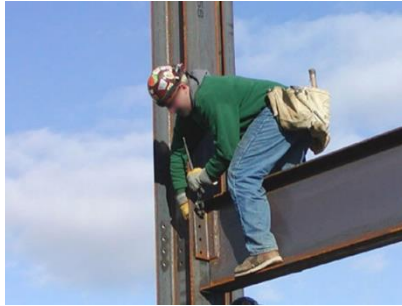
Gambar. 5 8 Pemasangan baut – baut sambungan
