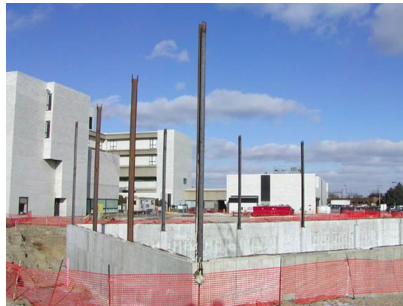
Gambar. 5 5 Kolom - kolom terpasang
