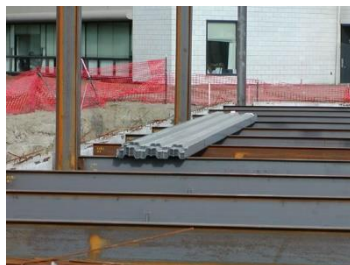
Gambar. 5 11 Pemasangan pelat bondek
