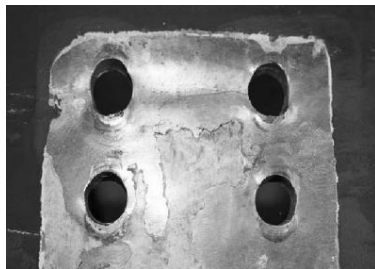
Gambar 2. 19 Deformasi akibat tumpu baut
