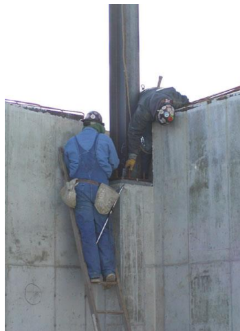
Gambar. 5 3 Pemasangan kolom ke pedestal
