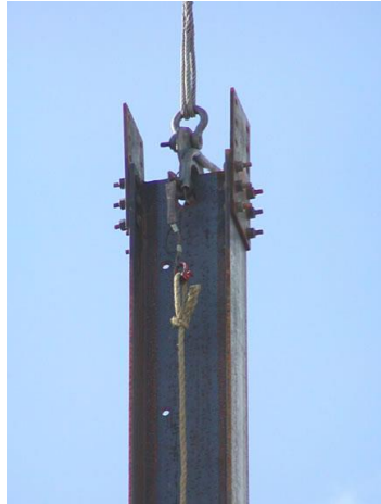
Gambar. 5 4 Kolom ditahan oleh crane
