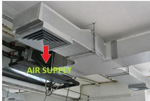
Gambar 2.9 Konstruksi ducting supply dengan diffuser
