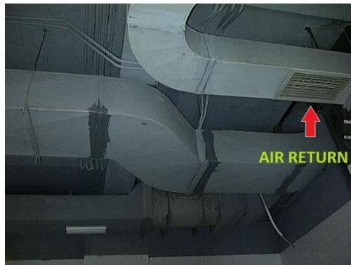
Gambar 2.10 Konstruksi ducting return dengan grille.
