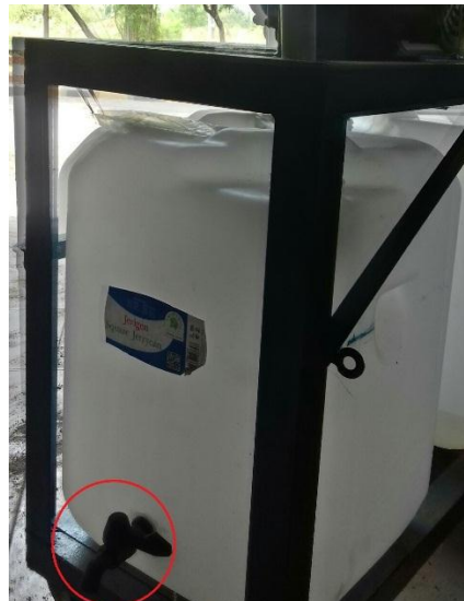
Gambar 3. 18. Katup untuk drainase tangki keluaran air
