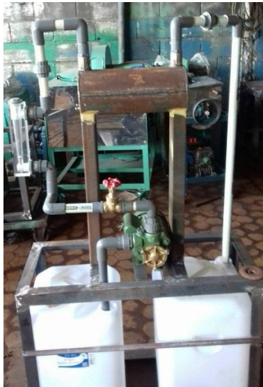
Gambar Pemasangan flow meter dan fitting
