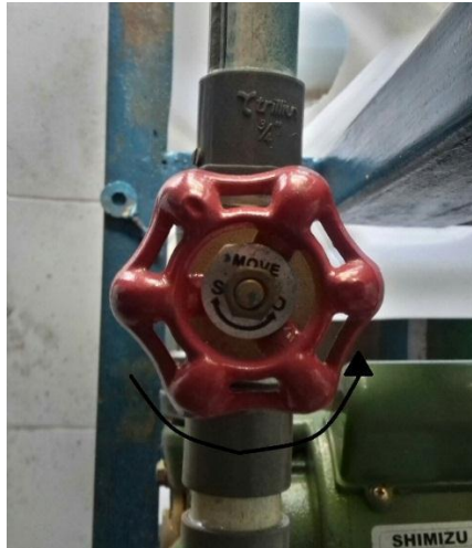
Gambar 3. 15. Katup untuk mengatur masukan air ke dalam vortex generator
