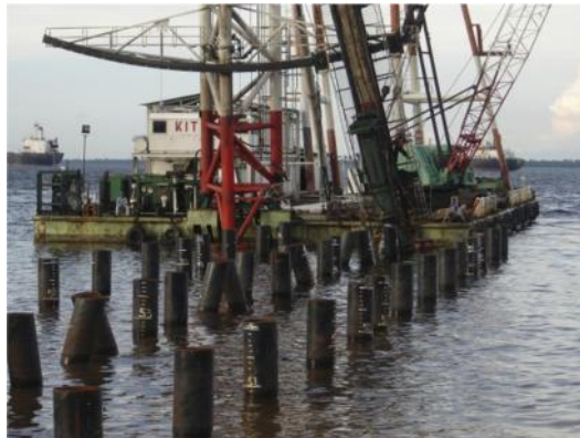
Gambar 8. 3 Pemancangan Tiang Pancang Baja
