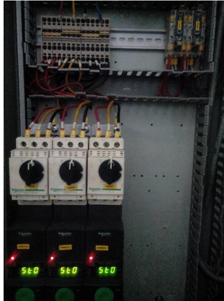
Gambar 4.14 Tampilan ketika safety relay tidak aktif
