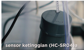
(a) Pemasangan sensor HCSR-04
