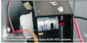
(a) Pemasangan motor peristaltic basa
