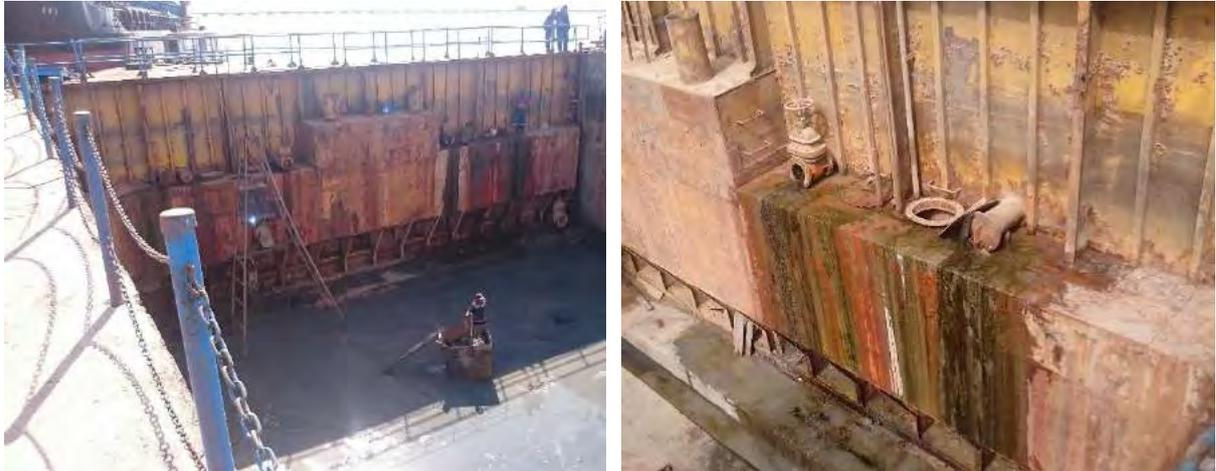
Gambar 4.5 Proses reparasi dinding dok (kiri) dan kebocoran yang terjadi pada pintu dok (kanan)
