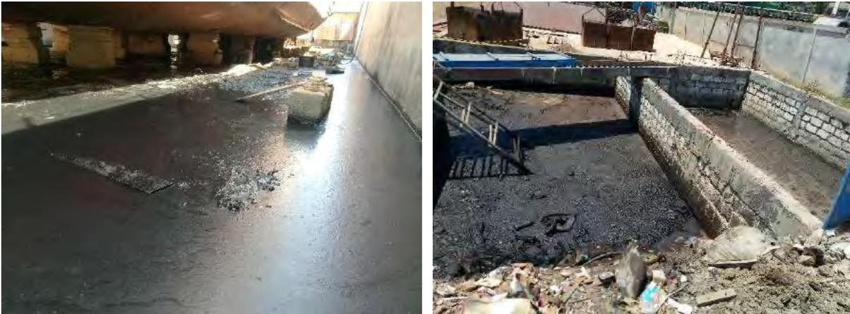
Gambar 4.7 Genangan pada *graving dock* akibat drainasi yang kurang baik (kiri) dan kolam lumpur (kanan)
