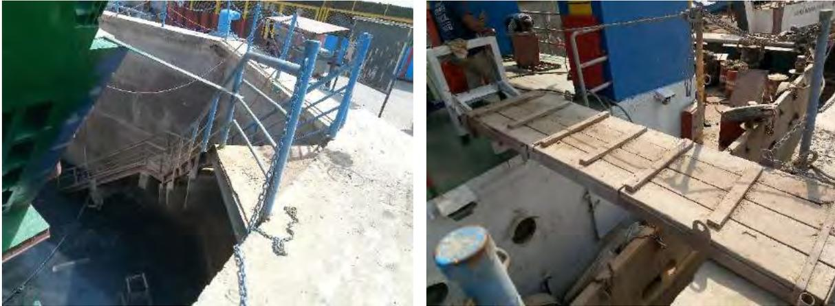
Gambar 4.18 Tangga di akses di bagian depan *graving dock* (kiri) dan alses dari bibir *graving dock* menuju kapal (kanan)
