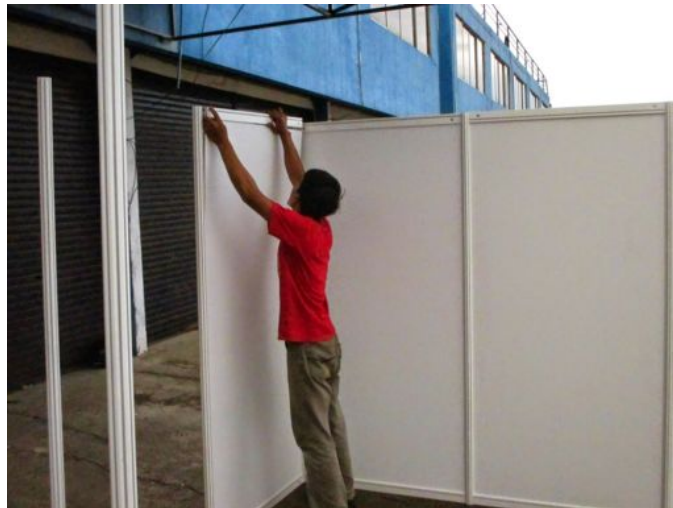
Gambar 4. 35 Pemasangan panel partisi
