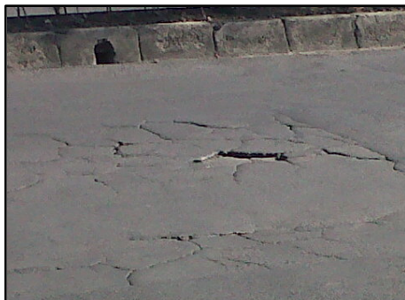
Gambar 1.4 Permukaan retak dan berlubang
