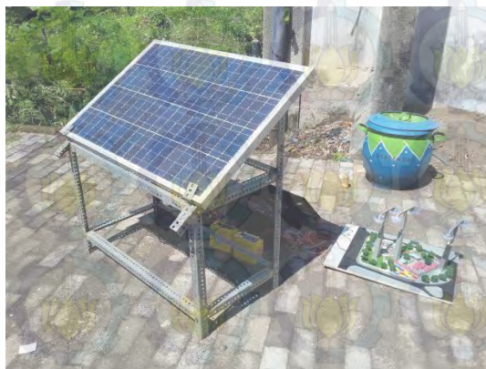
Gambar 4.20 Pengujian Keseluruhan Sistem Menggunakan Solar Cell
