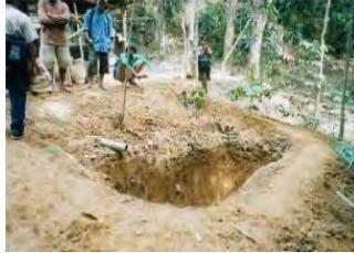
Gambar 2.4 Kolam *Tailing* pada Lokasi Penambangan Emas Rakyat Dsn. Sangon
