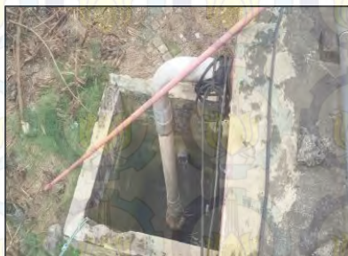
Gambar 5.6 Bak Equalisasi Eksisting Rumah Sakit X
