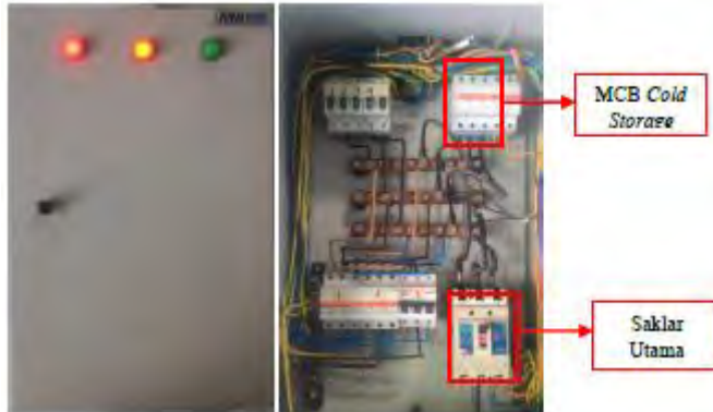
Gambar 3.20 Panel Listrik Utama
