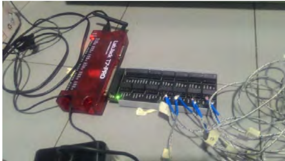
Gambar 3.24 Pemasangan Thermocouple ke Labjack T7-Pro
