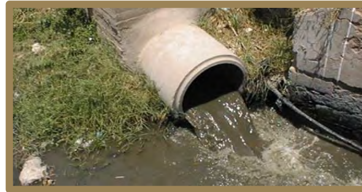
Les eaux usées
