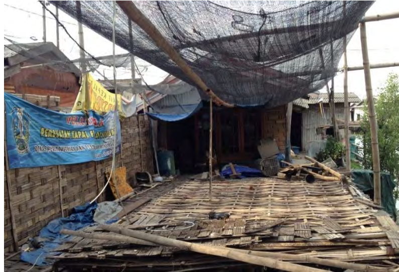
Gambar Area Pembangunan Kapal Pak "A"
