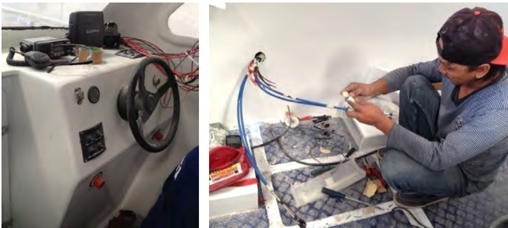
Gambar II.8 Instalasi Listrik dan Sistem Navigasi
