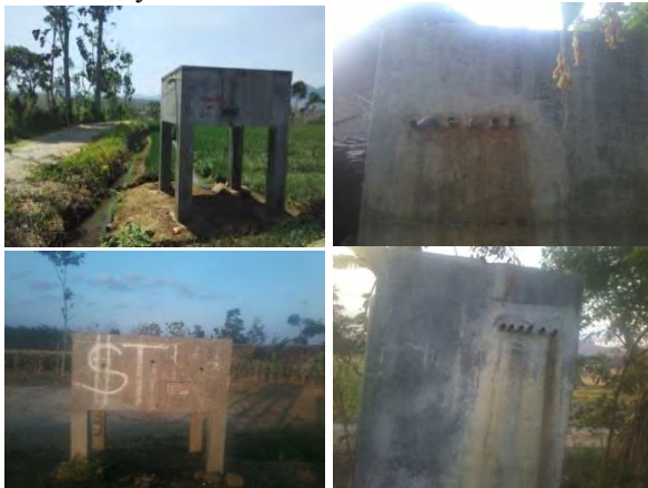
Gambar 4. 10 Kondisi Bangunan Sarana dan Prasarana WSLIC-2 di Dusun Jurugan yang Sudah Rusak
