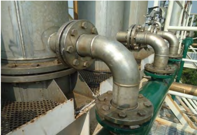
Gambar 4.14. Pengecekan pipa menuju kondensor unit
