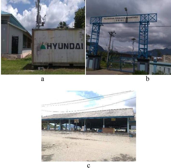
Gambar 4.12 Keberadaan Cold storage di Kawasan Prigi (a), Pelabuhan Perikanan Nusantara (b), dan TPI (c)
