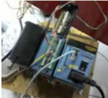
Gambar 3.19 Unit data akuisisi Yokogawa MX100
