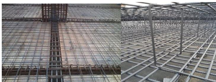
**Gambar 4.52.** Pemasangan Beton Tahu dan *Spacer Bar* Pelat
