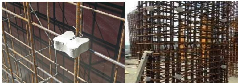
**Gambar 4.54.** Pemasangan Beton Tahu dan *Space Bar* Kolom dan Dinding Geser
