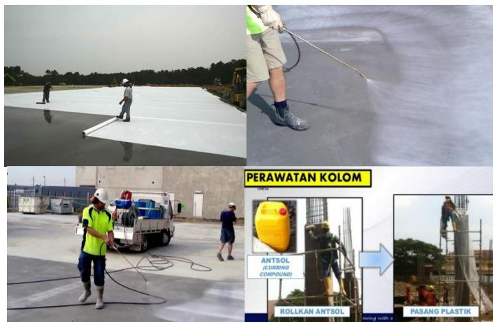
**Gambar 4.60.** Metode Perawatan Beton
