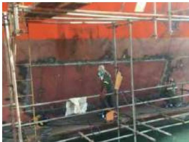
Gambar 2.5 *Replating* lambung kapal saat terapung
