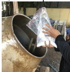
**Gambar 3.13** Memasukkan *Superplasticizer* ke Dalam *Mixer*
