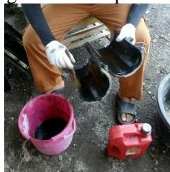
**Gambar 3.15** Melumuri *Bekisting* dengan Oli
