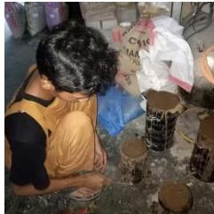
**Gambar 3.16** Meratakan Permukaan Beton Geopolimer
