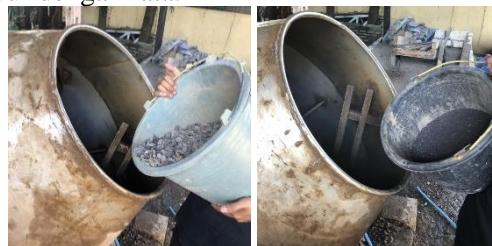
**Gambar 3.12** Memasukkan Kerikil dan Pasir ke Dalam *Mixer*
