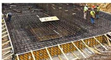
**Gambar 5. 6** Pemasangan Tulangan *Raft Foundation*
