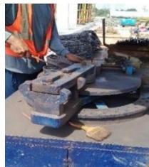
**Gambar 5.8** Proses Fabrikasi Tulangan Kolom
