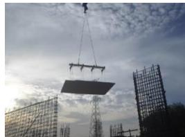
**Gambar 5. 22 Pengangkatan *Half Slab Precast***
