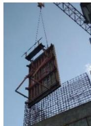
**Gambar 5. 17** Pemasangan Bekisting *Shearwall*
