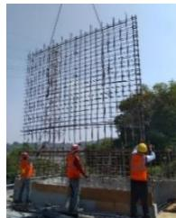
**Gambar 5. 14** Pemasangan Tulangan *Shearwall*
