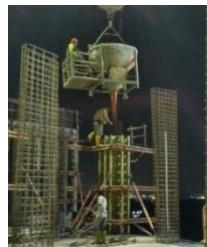
**Gambar 5. 12 Proses Pengecoran Kolom**
