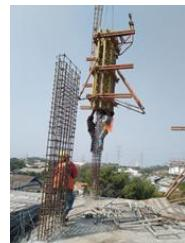
**Gambar 2. 9** Pemasangan Bekisting Kolom
