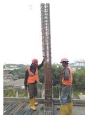
**Gambar 2. 7** Pemasangan Tulangan Kolom
