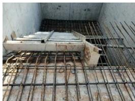
**Gambar 5. 25** Pemasangan Bekisting Anak Tangga
