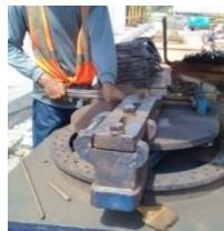
**Gambar 5. 13** Proses Fabrikasi Tulangan *Shearwall*
