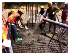
**Gambar 5. 7** Proses Pengecoran *Raft Foundation*
