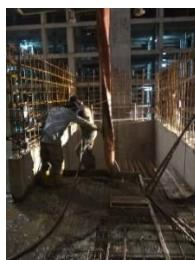
**Gambar 5. 27** Proses Pengecoran Tangga
