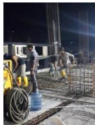
**Gambar 5. 24 Pengecoran Pelat Lantai**
