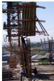
**Gambar 5. 11** Pemasangan Bekisting Kolom
