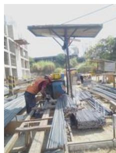
**Gambar 2. 6** Pemotongan Tulangan
