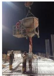
**Gambar 5. 21** Proses Pengecoran Balok
