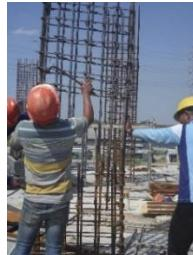
**Gambar 5.9** Pemasangan Tulangan Kolom
