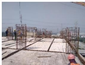
**Gambar 5. 23** Pemasangan Half Slab Precast
