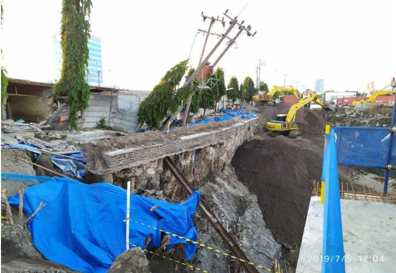
**Gambar 1.1** Kelongsoran pada dinding penahan di lapangan
