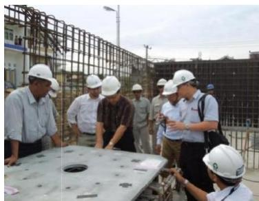
Gambar 9. 5 Pemasangan Base Plate
