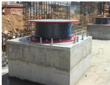
Gambar 9. 14 Pemasangan Top Plate
