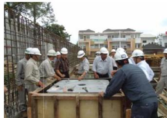
Gambar 9. 7 Pemasangan Bekisiting Kolom Pendestal Bawah
