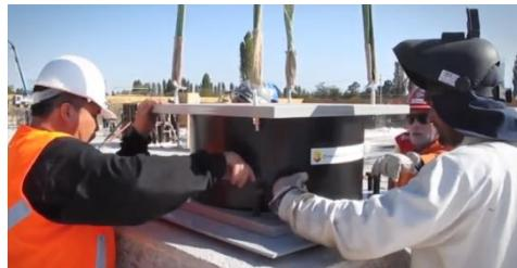
Gambar 9. 13 Pemasangan Baut Bawah
