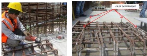
Gambar 9. 4 Pemotongan Besi Dudukan Base Plate
