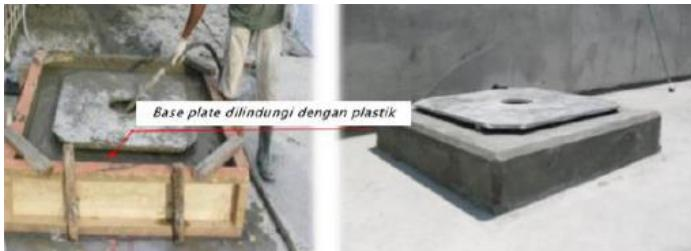
Gambar 9. 8 Pengecoran Kolom Pendestal Bawah
