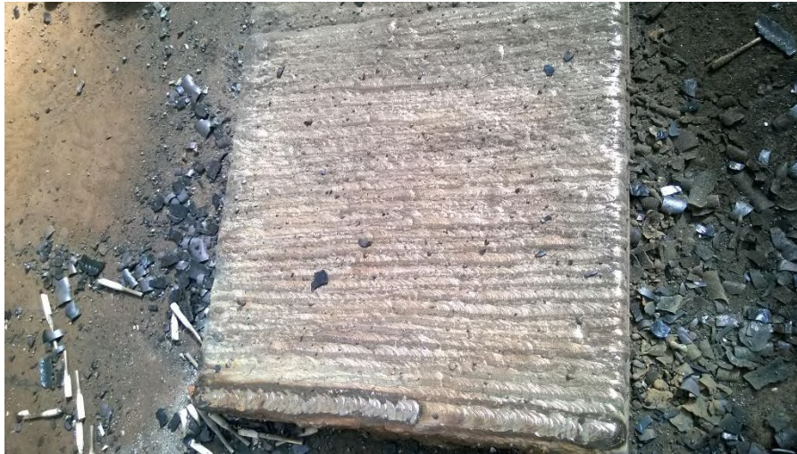
Gambar 3.3. Proses pengerjaan cladding overlay
