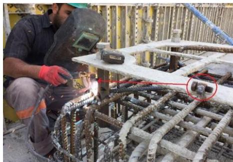
Gambar 3. Pengelasan dowel pada tulangan dan baut
