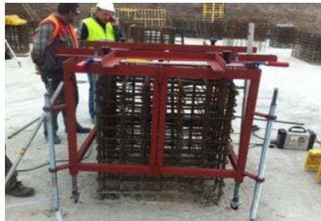
Gambar 2. Pengaturan elevasi *steel gage* dan *dowels* dengan “*red table*”
