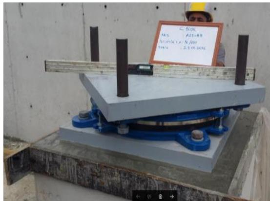
Gambar 8. Proses grouting bagian bawah *base plate*
