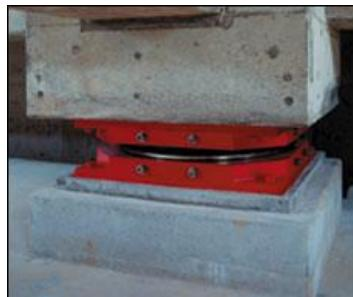
**Gambar 2.10** Pemasangan FPS Pada Kolom Pedestal yang Pendek
