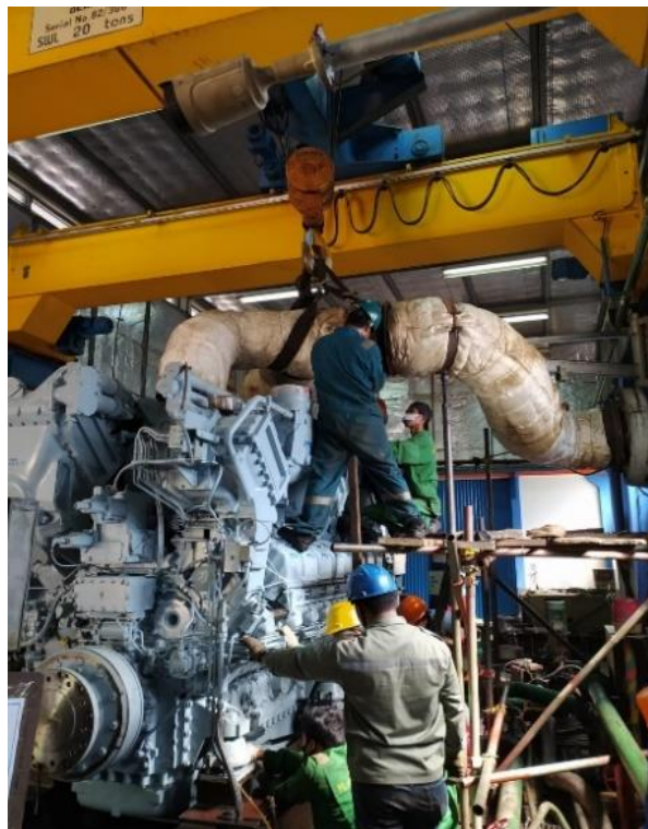
Gambar 3.3 Proses Pemasangan Sistem pada Engine
