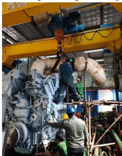
Gambar 3.3 Proses Pemasangan Sistem pada Engine
