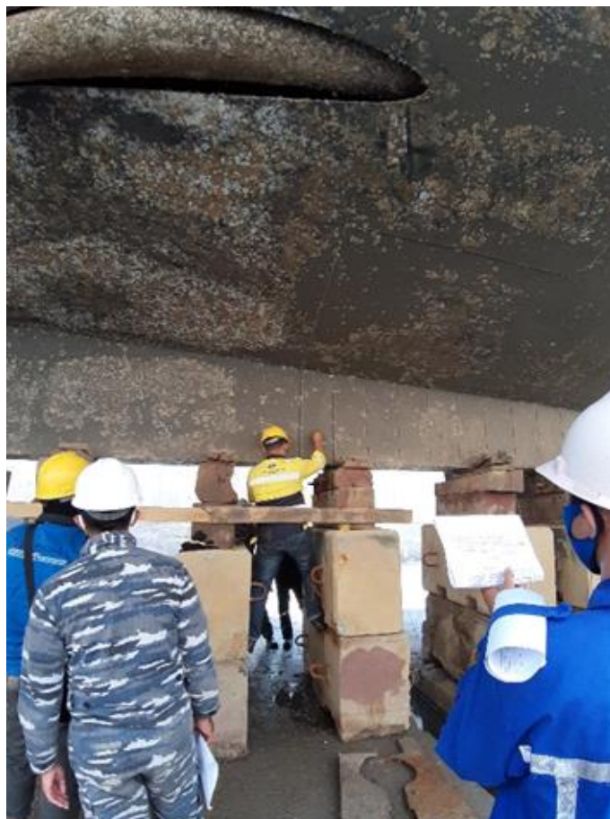
Gambar 5.16 Proses Verifikasi Pengukuran Tebal Plat
