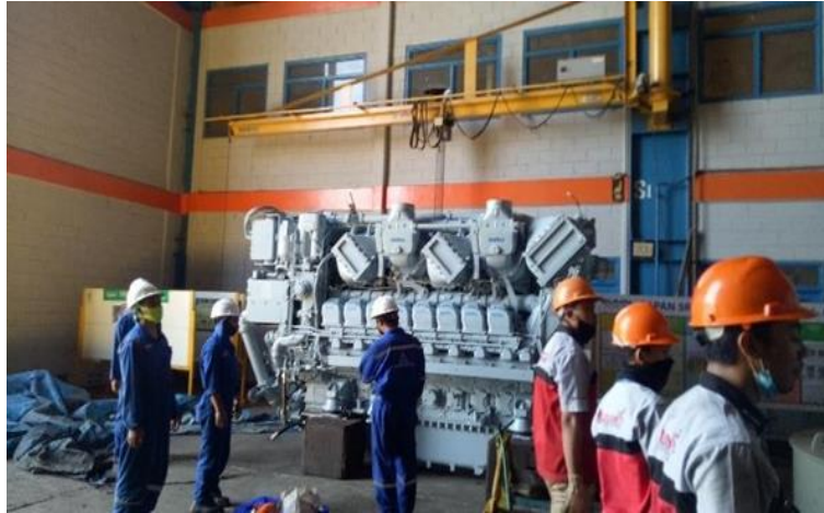
Gambar 3.1 Proses Loading Engine KRI Teluk Celukan Bawang
