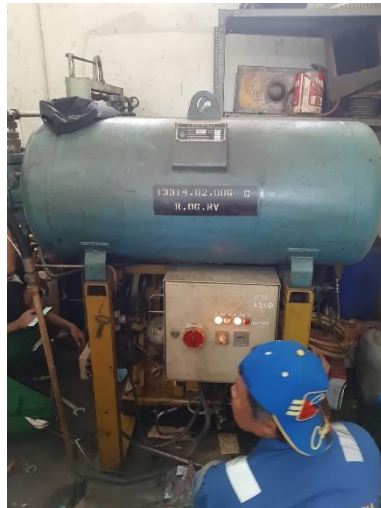
Pemeriksaan (Overhaul) kompresor test bench
