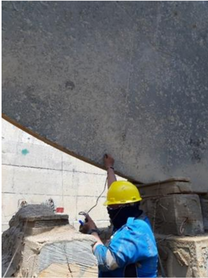
Gambar 5.14 Proses Pengukuran Tebal Plat dengan Ultrasonic Test (Sumber : Dokumen Penulis)
