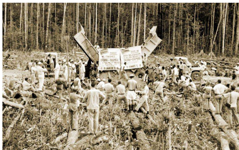
Gambar 1.3 Pembangunan konstruksi jalan Duri-Dumai 1958
