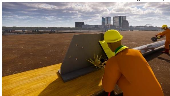
**Gambar 6. 2** Pengelasan Sambungan Baseplate
