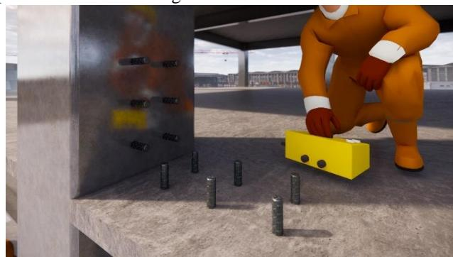
**Gambar 6. 4** Pemasangan Baut Angkur
