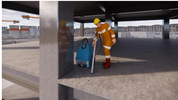
**Gambar 6. 3** Pembersihan Lubang Untuk Angkur
