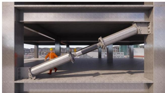
**Gambar 6. 7** Pemasangan FVD ke Profil HSS Bulat
