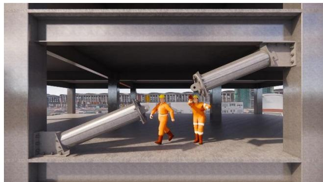
**Gambar 6. 6** Pemasangan Profil Baja HSS Bulat
