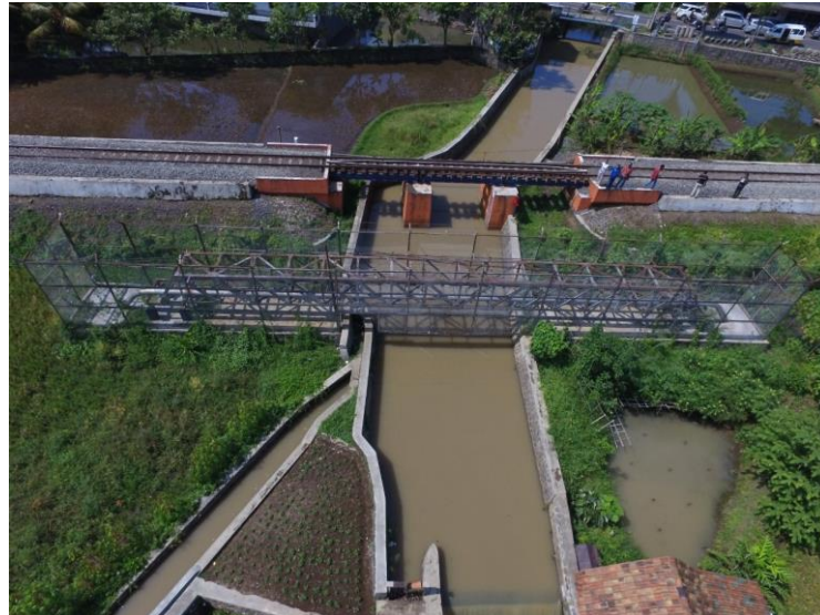
Gambar 3. 1 Kondisi Eksisting Jembatan Condong KP 124+400
