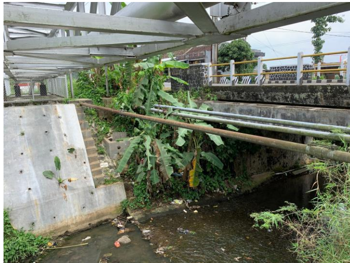
Gambar 4. 1 Pipa PDAM pada clearance area
