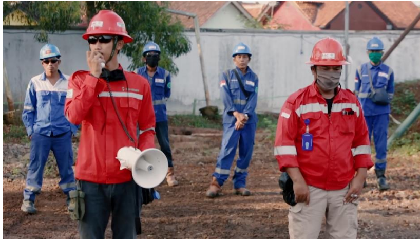
Gambar 5.4. 1 Penggunaan APD di laydown
